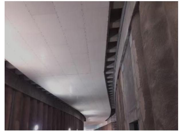
VÍAS NUEVAS DE LIMA TUNNEL, PERU
